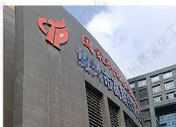
铝塑板外墙翻新
